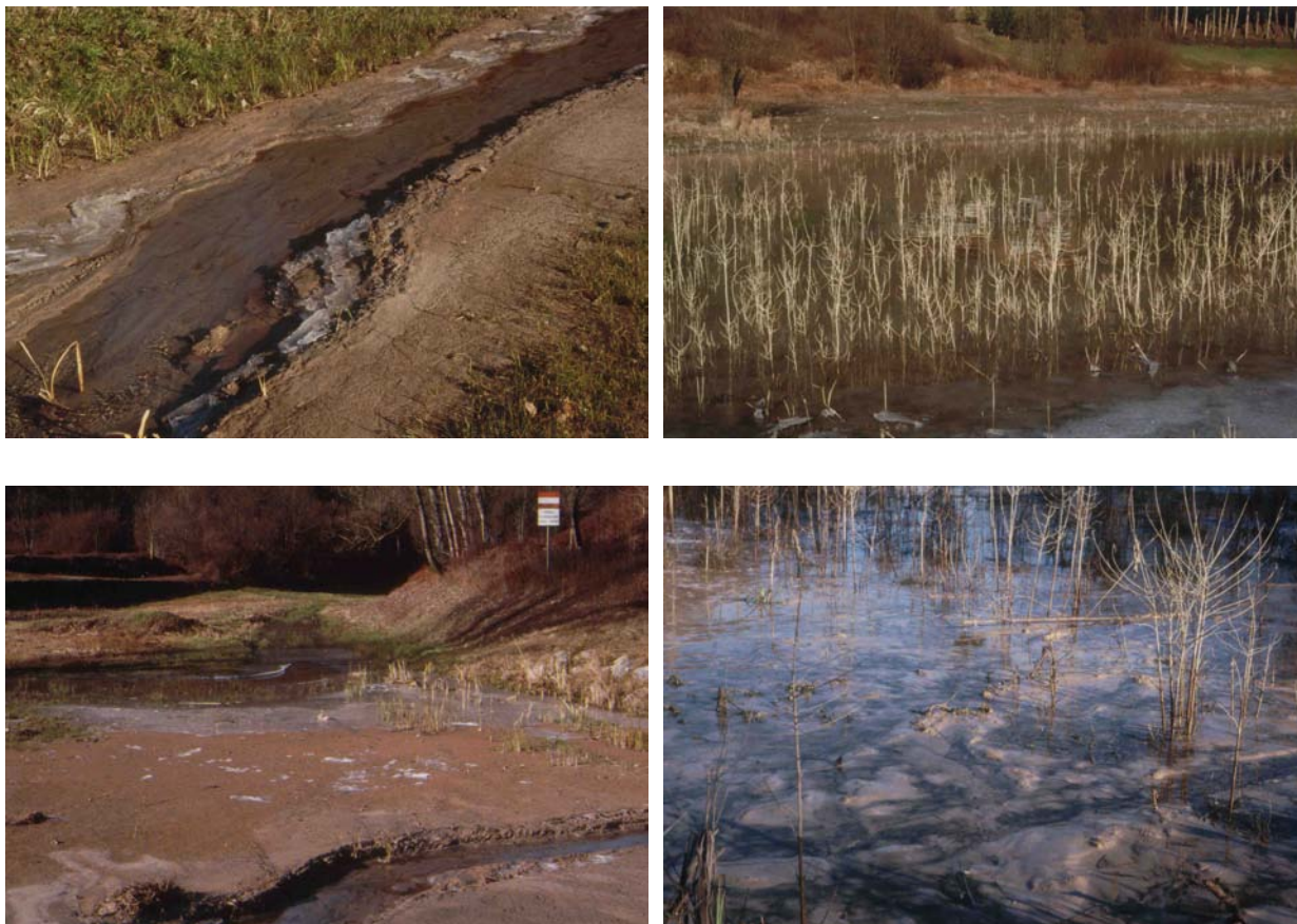
Fig. 1-4. Vedute invernali (2005) della porzione terminale del Lago d’Idro poco a monte dell’opera trasversale di regimazione. Sono evidenti gli effetti degli scarichi di una vicina cava d’estrazione di inerti.
